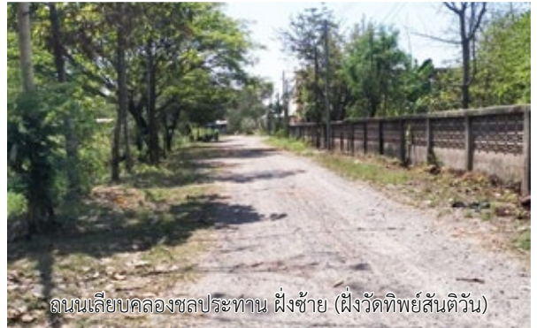
ถนนเลียบบคลองทางรถไฟบ้านหนองเหล็ก
